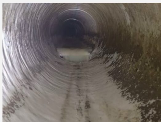
Garantieabnahme: Inliner in gutem Zustand
