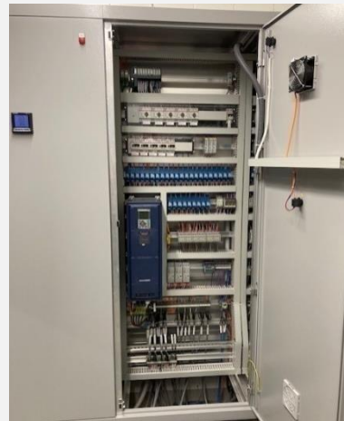
Ausbau Steuerung NFR + und Tank
