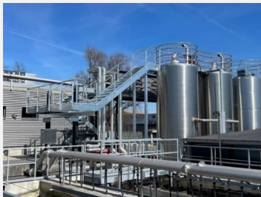
Neuer Treppenaufstieg zu den Tanks
