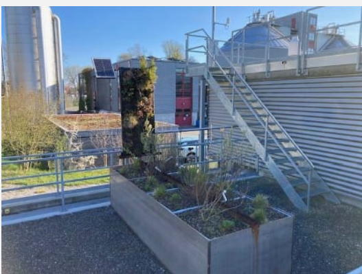
Schwammstadtmodell beim Zwischenhebewerk
