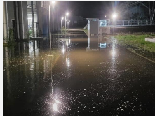
Überlaufende Filter führten zu einer Überflutung
