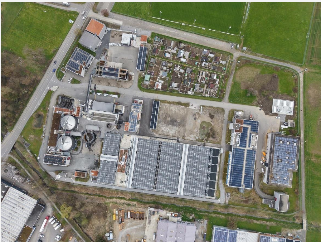
Stand März 2026: Erweiterung PV-Anlagen beim Fahrzeugunterstand und Frischschlammeindicker, Neubau Gasometer 2, Erweiterung Lagerplatz IBC-Gebinde. Beginn von Renaturierungsarbeiten auf dem ehemaligen Baustelleninstallationsplatz und Bau Batteriespeicher
