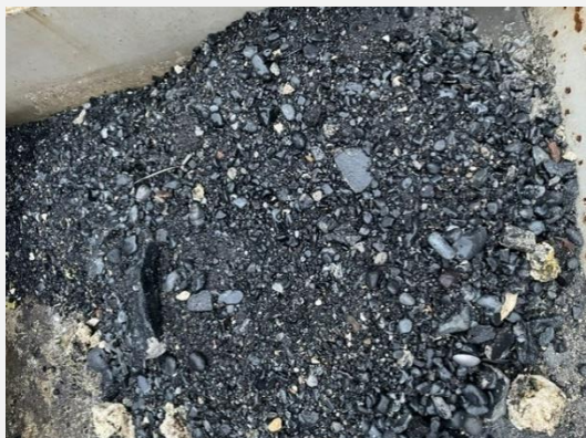
Materialablagerungen in Zone 8
