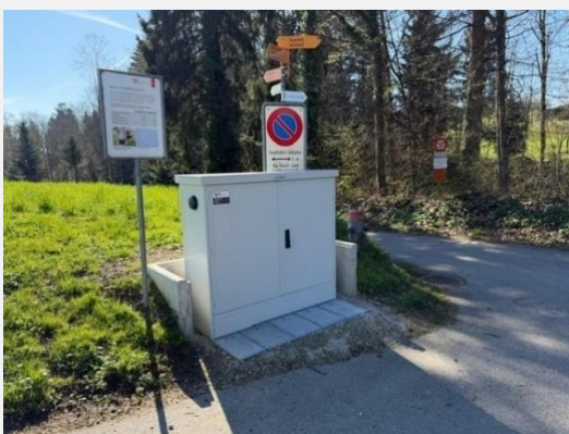
RB Watt, neu positionierte Verteilkabine
