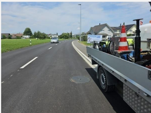
Anpassungsarbeiten bei einem Schachtdeckel in der Tübacherstrasse
