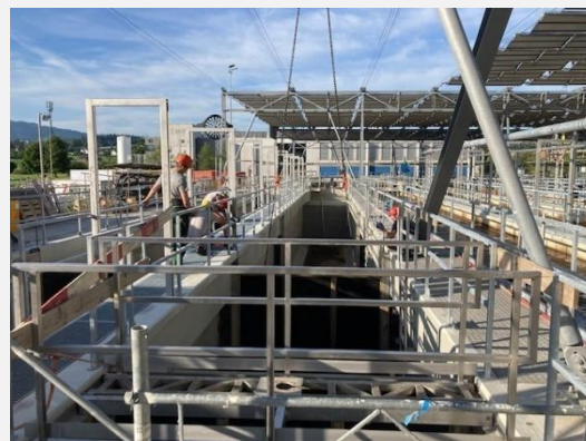
Einbau Tauchwände in Biologiestrasse 1
