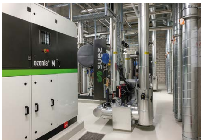
Aus Sauerstoff (O 2 ) wird im Ozongenerator Ozon (O 3 ) hergestellt.
