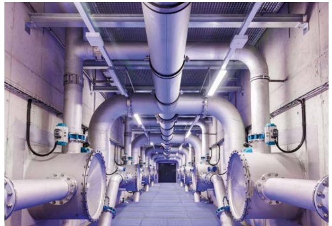
Die Anlage wird mit maximal 900 Liter Abwasser pro Sekunde betrieben.
