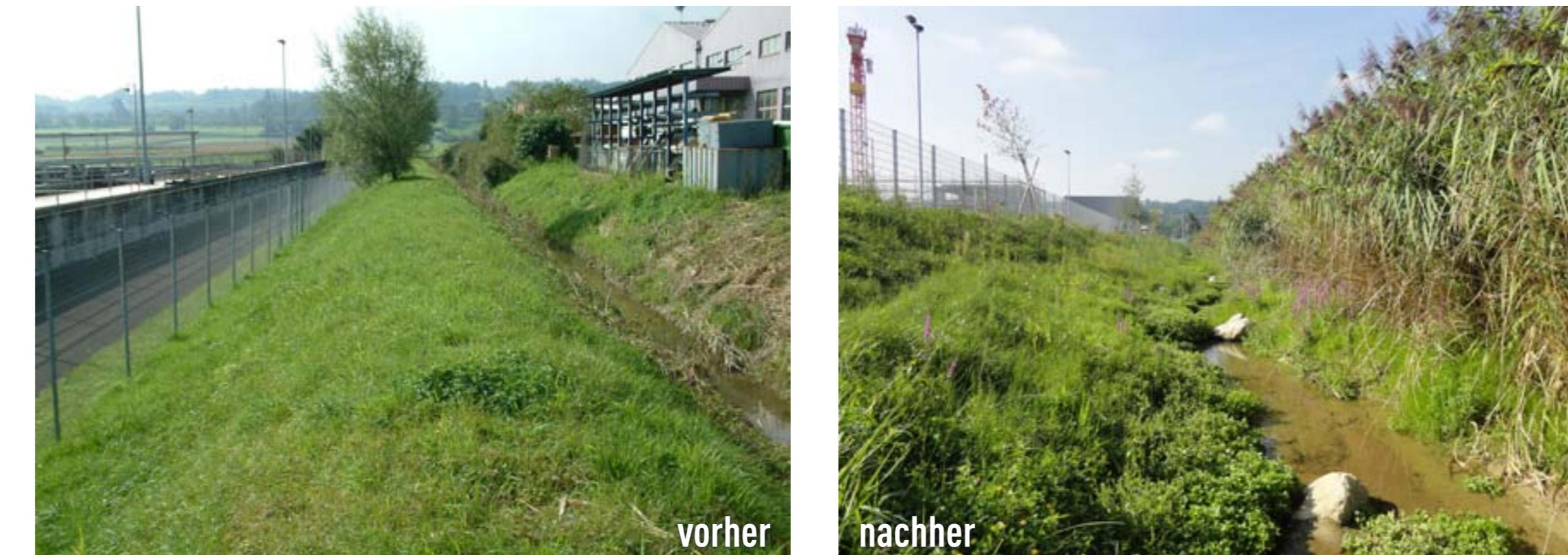
Der kanalisierte Bach, hydraulisch zu klein und eintönig, hat dank dem Neubau des Ableitungskanals des AVM ein grösseres, variables und ökologisch wertvolles Bachbett erhalten. Die Hochwassergefahr ist gebannt, verbesserter Lebensraum ist entstanden.
