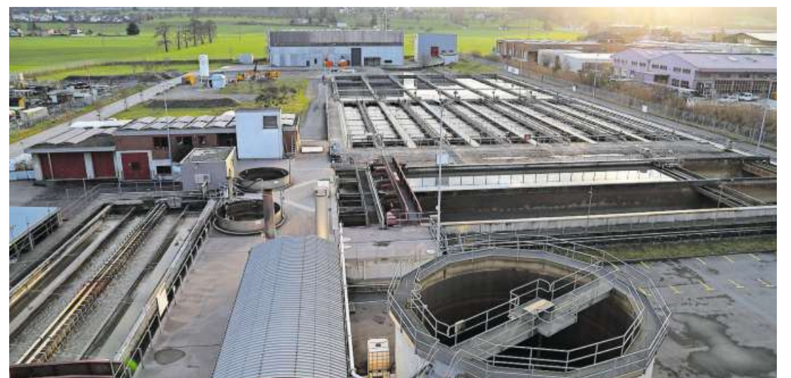
Interessierte können am Samstag die Kläranlage in Steinach besichtigen.
