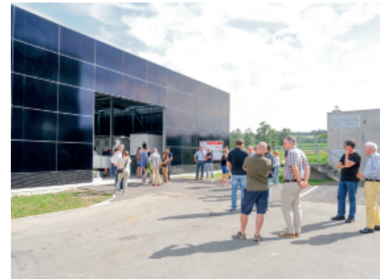
Der Batteriespeicher und die Power-Hall wurden feierlich eingeweiht. sam
